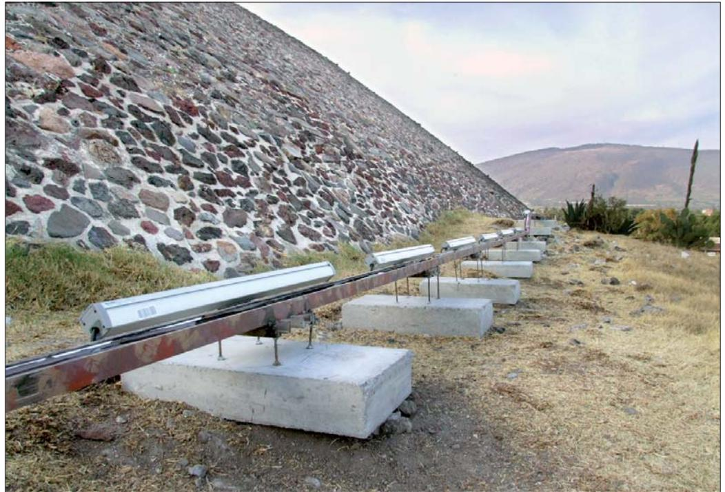
Trabajadores de la empresa Mundo comenzaron a retirar los rieles metálicos instalados con tornillos, que servirían de base para las luminarias en las pirámides del Sol y de la Luna, y a colocar en su lugar bloques prefabricados de concreto ■ Foto Javier Salinas Cesáreo
